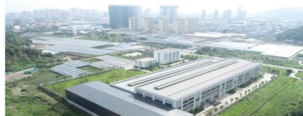
黄岩项目炉渣资源化处理车间
