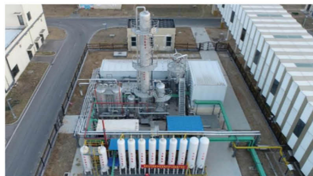
青岛西海岸静脉产业园沼气提纯项目现场
