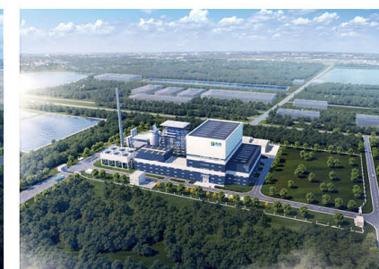
泰国暖武里一期项目
