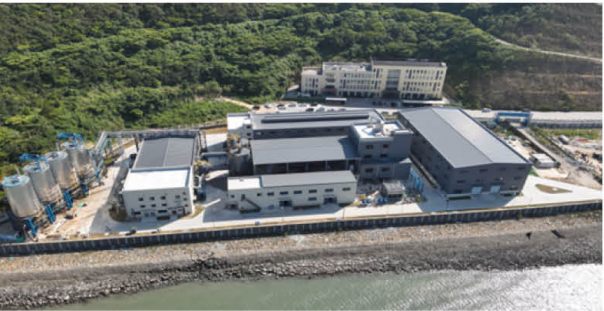
宁波项目飞灰资源化处理车间
