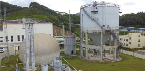
梧州静脉产业园餐厨项目
